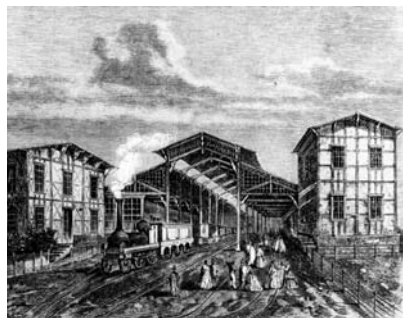
Dworzec jeżycki – pierwszy dworzec kolejowy w Poznaniu
