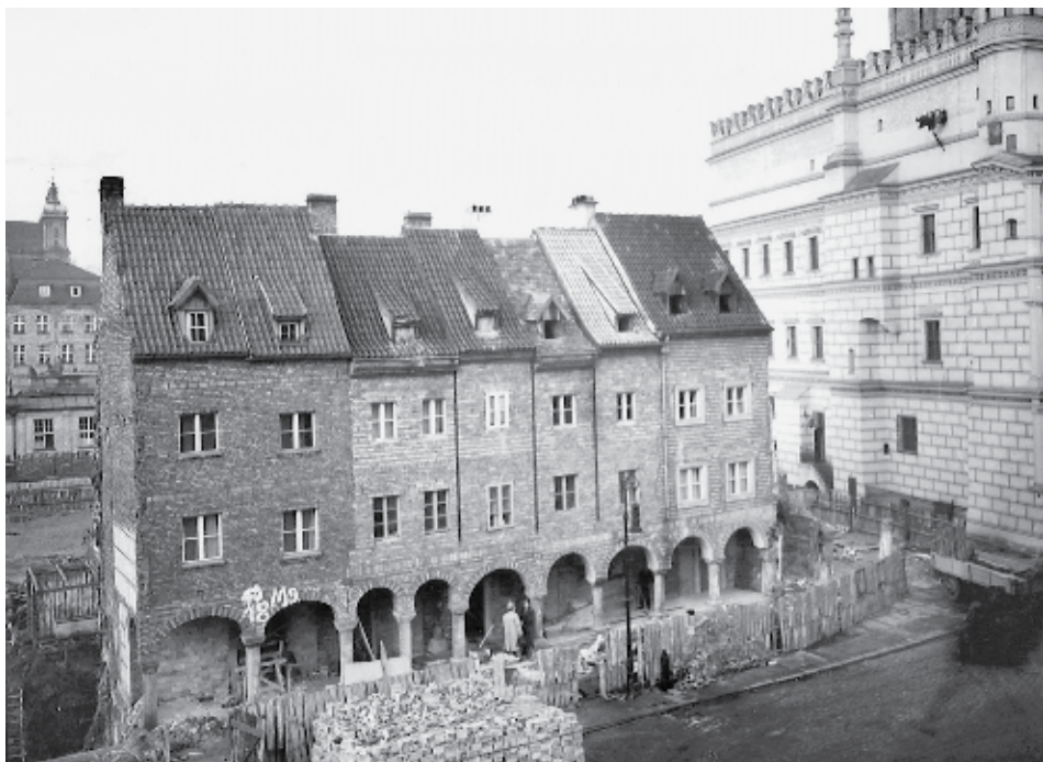
Rekonstrukcja domków budniczych, 1954. Źródło: Miejski Konserwator Zabytków w Poznaniu.
